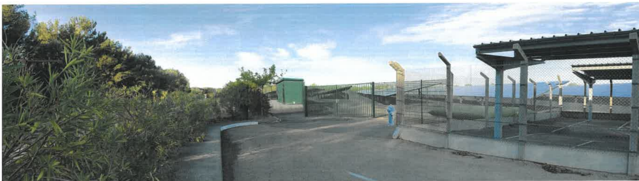
Photographie 61 : Vue projetée du projet du parc photovoltaïque depuis l'accès
