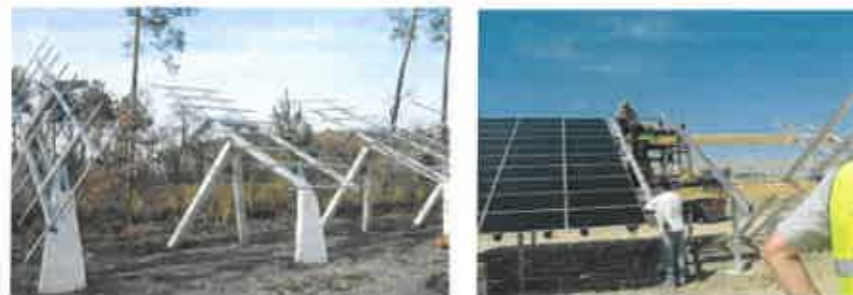
Figure 17: Montage des supports de la technologie « trackers » (à gauche), montage de modules sur des supports fixes (à droite) Source : EDF Renouvelables
