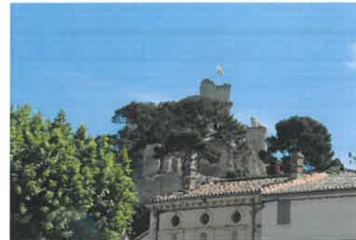
Photographie 26 : le château (ruines) à Boulbon
