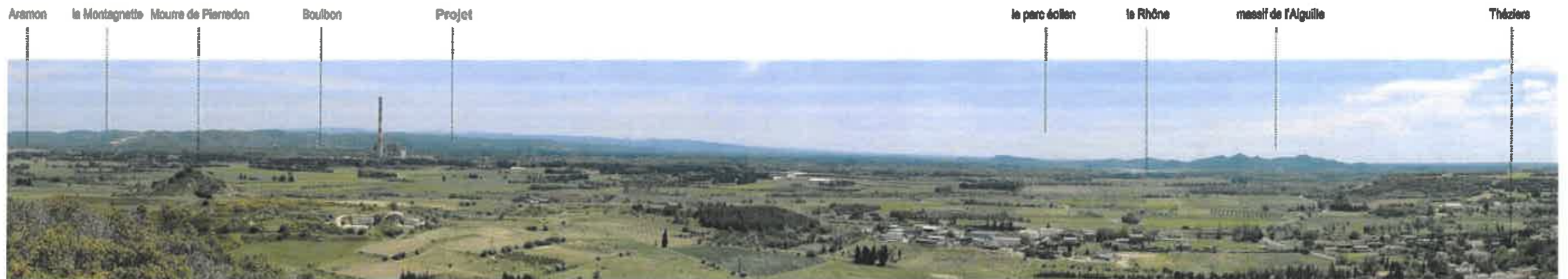
Photographie 54 : Vue projetée avec le projet du parc photovoltaïque depuis les hauteurs de Théziers (le Castellias)
