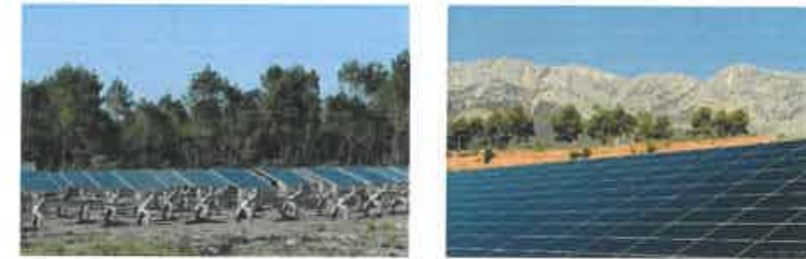
Figure 6: Structures solaires (à gauche: les trackers de la centrale de Gabardan (40) qui suivent le soleil ; à droite : structures fixes à Puylobrier (13)) - Source : EDF Renouvelables
