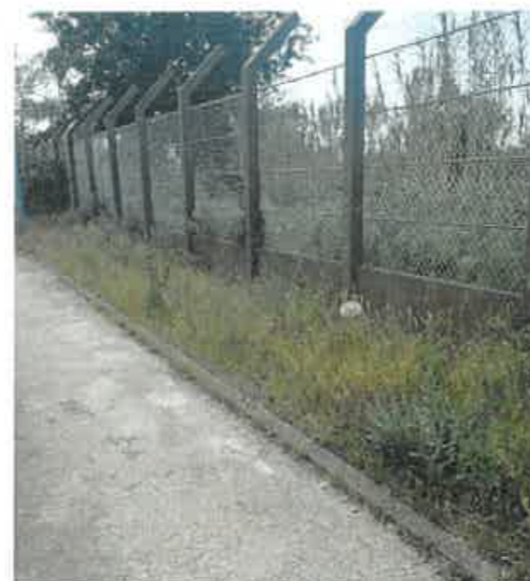
Figure 59 : Clôture ne laissant pas circuler la petite faune (Source : Y. RONCHARD)
