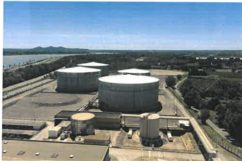
Figure 117: Vue depuis la cheminée (source EDF)
