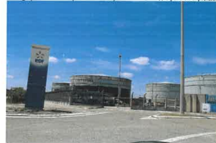
Photographie 36 : Vue depuis l'entrée du site
