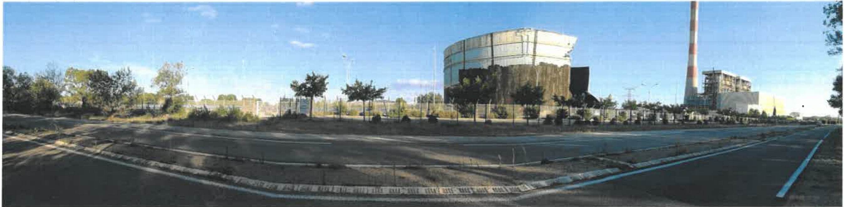
Photographie 58 : Vue initiale depuis la route départementale 2
