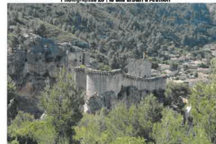
Photographie 30 : les abords du château fort à Boulbon
